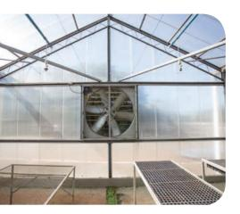
Quando os sensores internos acusam alta temperatura e baixa umidade, os exaustores são acionados e forçam a entrada de ar pela parede permeável oposta. O ar circulante se umedece e se resfria, mantendo o ambiente interno úmido e mais frio que o externo.
