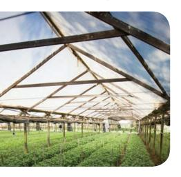
O plástico (polietileno de alta densidade com ativação) pode ser leitoso, transparente ou difusor de luz, com diferentes espessuras, adequado a cada necessidade. A definição do melhor tipo de plástico a ser utilizado se dá pela combinação entre as espécies cultivadas e as condições de luminosidade local.
